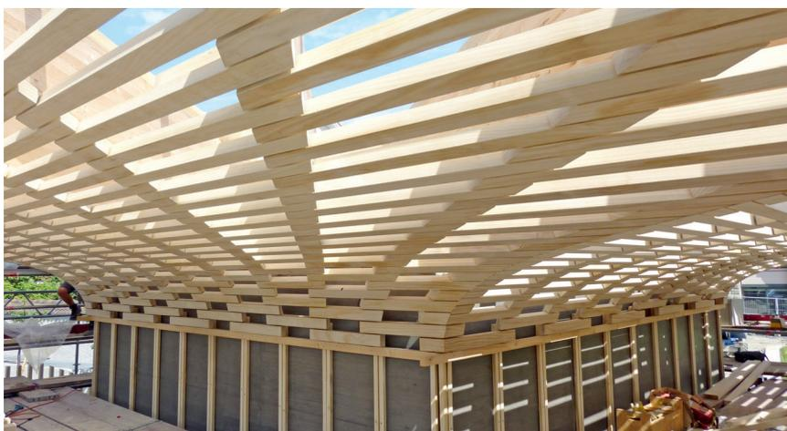
**Die massgenaue Vorfertigung der Auskleidungselemente für die BSH-Tragstruktur erwies sich vom Anfang (links) bis zum Ende der Montage (rechts) als die richtige Massnahme.**
