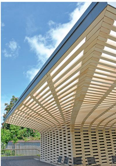
**In der Art der Auskleidung bisher einmalig, darum eine Premiere, ist die Verwendung von stabförmigen, auf Abstand montierten Lamellen für die mit vorgegebenen Radien auszuführenden Rundungen. Die gestalterische Idee wie die Qualität der handwerklichen Ausführung beeindrucken gleichermaßen.**
