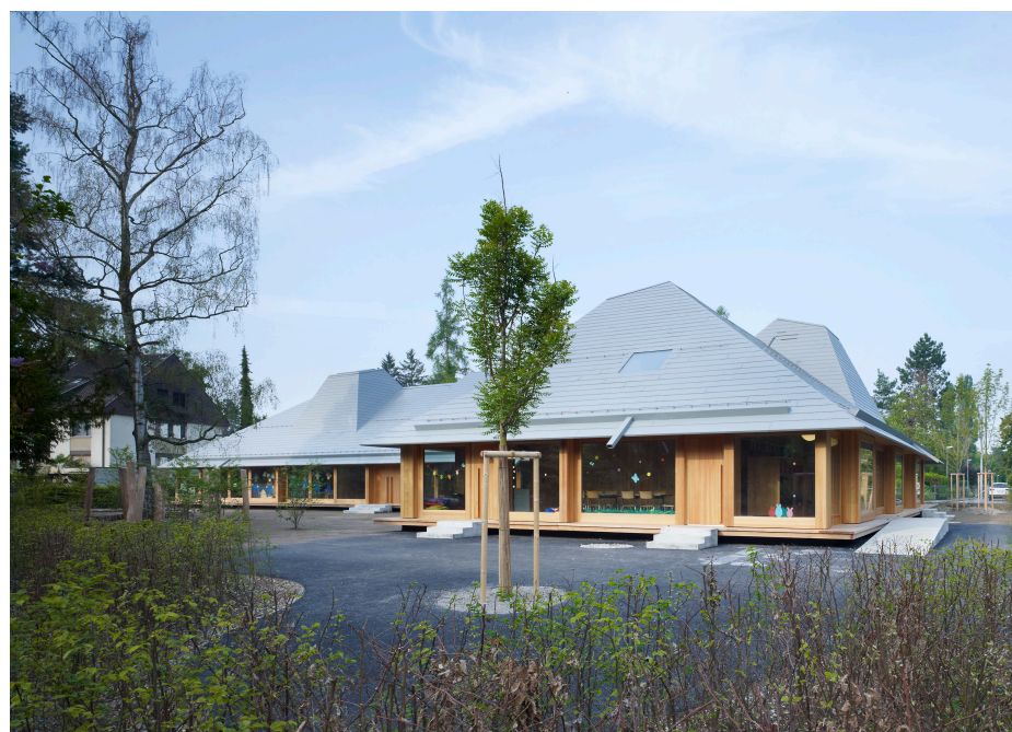
Aussenansicht des Doppelkindergartens Paradiesstrasse in Riehen.
