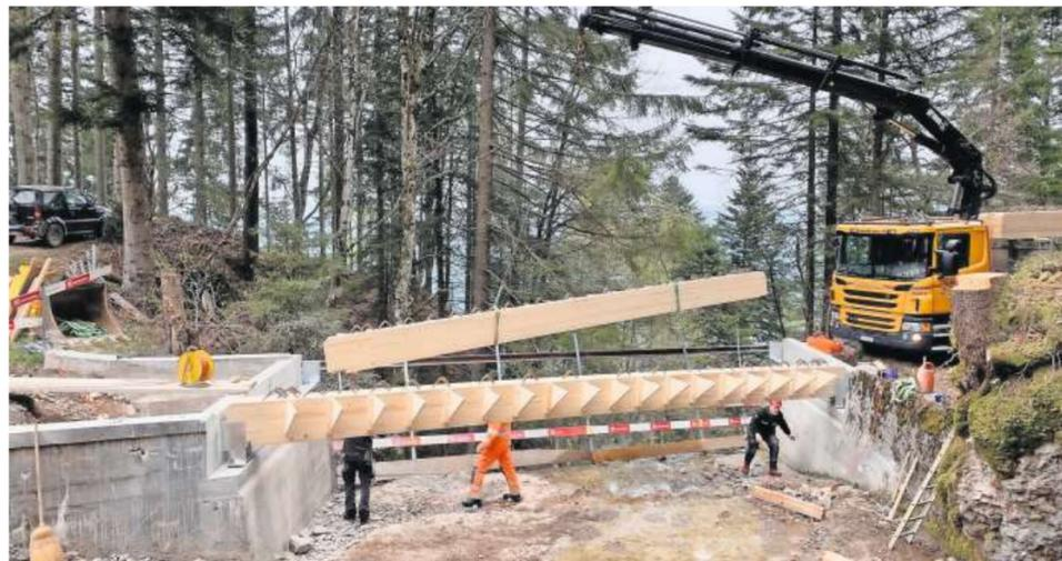
Die neue Holzbrücke hat eine Traglast von 40 Tonnen. Bild: PD
