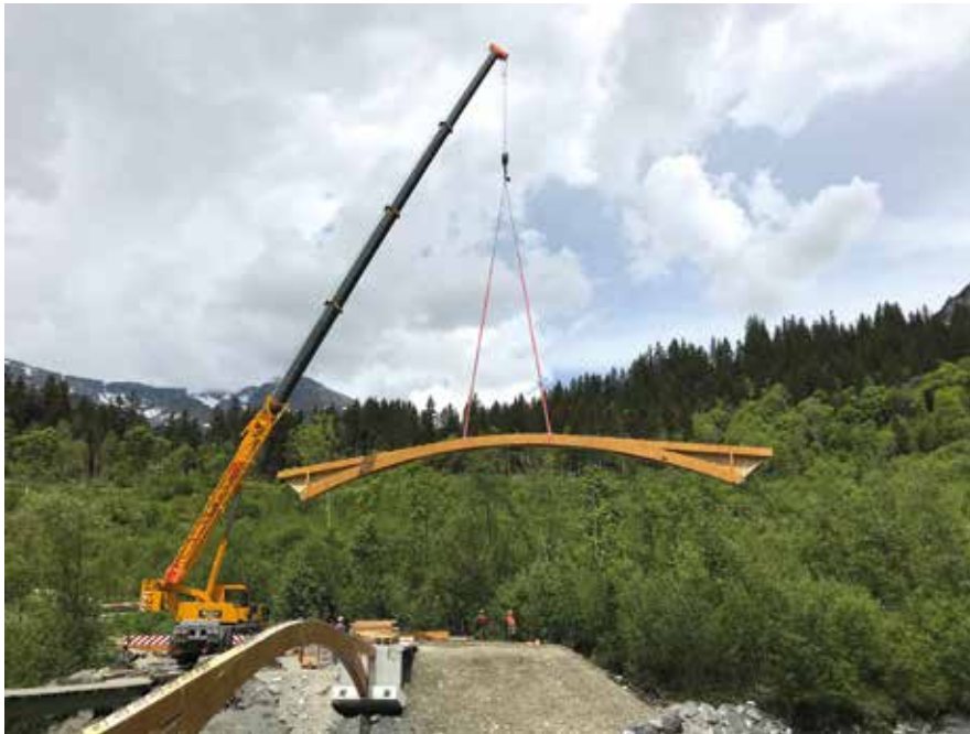
14 Montage der Längsträger Brawand Zimmerei AG
