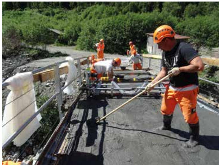
16 UHFB-Einbringung mittels Tremixbalken © Emch+Berger AG Bern
