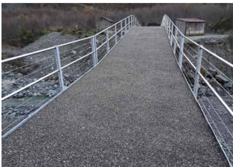
17 Brückenoberfläche nach Fertigstellung © Emch+Berger AG Bern
