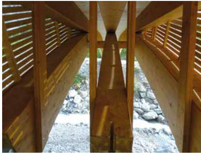
9 Struktur des Holzunterbaus © Emch+Berger AG Bern
