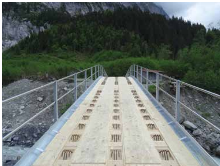
15 Vorgefertigte Schalungselemente mit Geländer © Emch+Berger AG Bern
