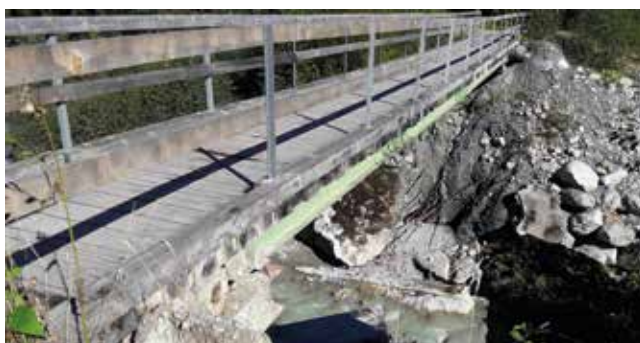
3 Zu ersetzendes Brückenprovisorium © Emch+Berger AG Bern
