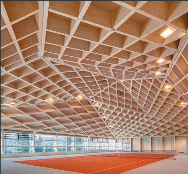
New tennis halls, Bürgenstock Hotels & Resort, Obbürgen 7)
