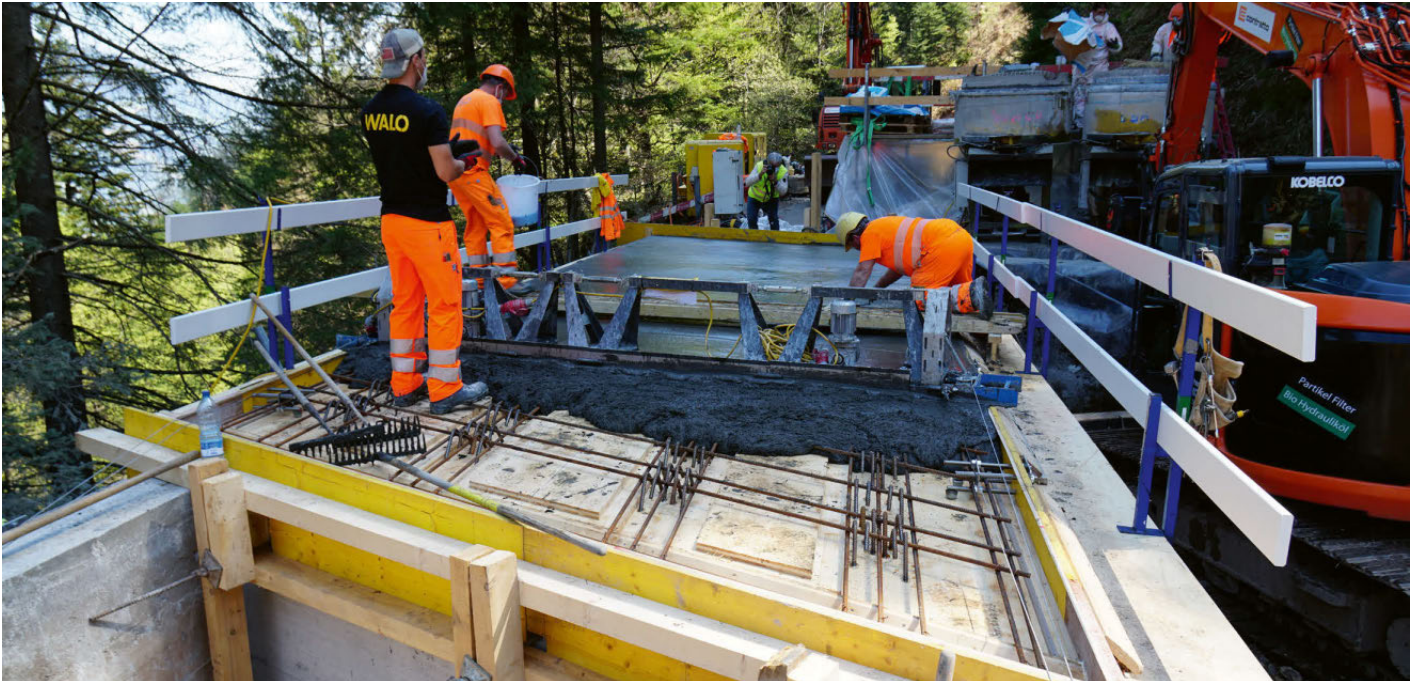
Ausführung der UHFB-Arbeiten: Der flüssige UHFB wird in die verlorene Schalung gegossen. Ebenfalls sichtbar ist das Schubverbundsystem mit GSA-Technologie.
