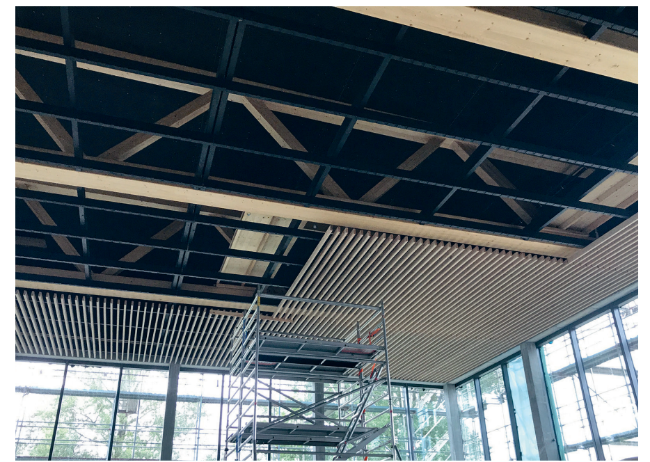
Die Montage der Deckenverkleidung aus sägeroheren Douglasienlamellen.
