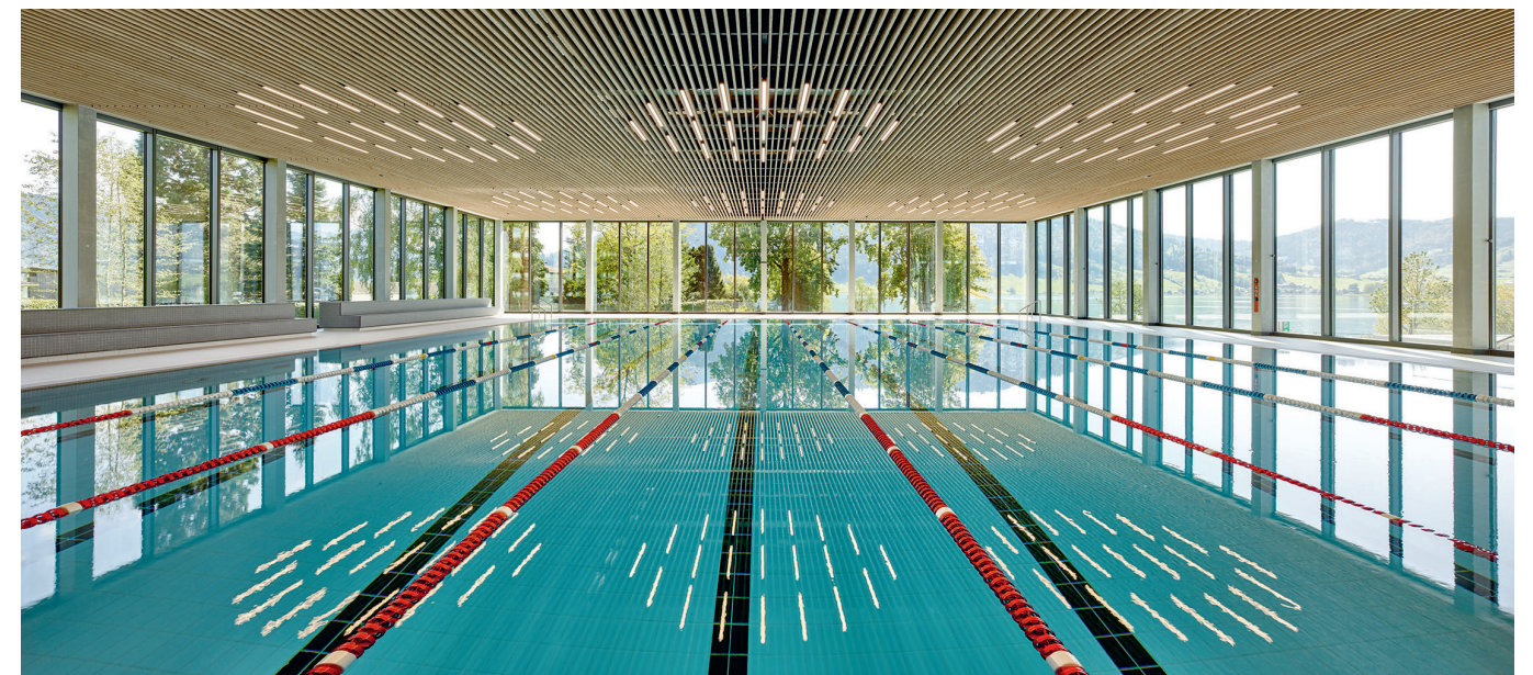
Mehr als 10 000 Meter Lamellen verbaute die Urs Iten Holzbau AG unter den Decken des Freizeitbads in Oberägeri.
