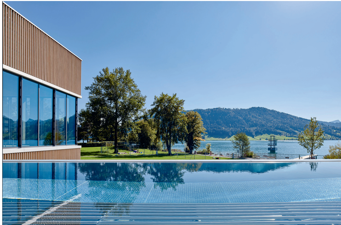
Die Architekten wie auch die Ägeribad AG als Bauherrin legen grossen Wert auf eine Materialisierung mit viel Holz und Glas. Die Badegäste dürfen sich an der traumhaften Aussicht über den Ägerisee erfreuen.
