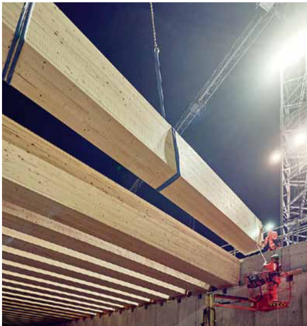
1'835 m 2 druckimprägnierte CLT-Platten über den Trägern
