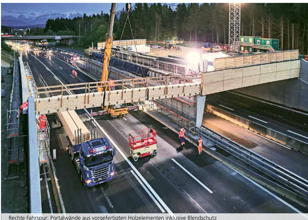
1'835 m 2 druckimprägnierte CLT-Platten über den Trägern
