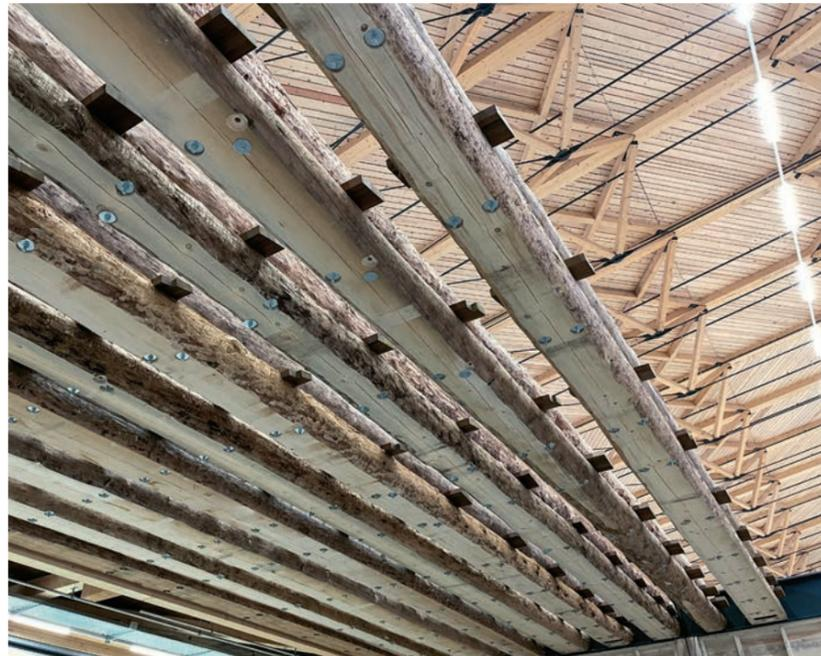
Die Zwischenböden sind mit Flecklingen realisiert. Darunter auch Käferholz, das im Konstruktionsbau produktiv verwertet werden kann.
