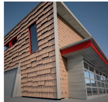
Die Visualisierung zeigt, wie die Fassade später aussehen wird: ein Holzvorhang mit Holzschindeln, die wie beim HolzEcht-System mit Holzdübeln verankert werden.
