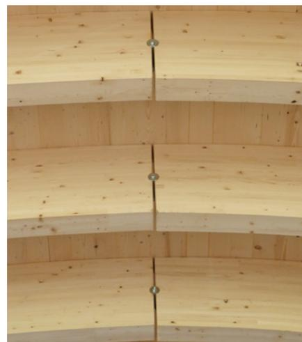
Gezielte Krafteinleitung, ob beim Auflager, am Firstscheitel oder in den Rahmenecken, mit der GSA-G Verbindung gelöst
