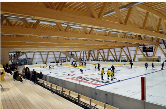
Mit Fachwerkträgern, wie hier für die neue Trainingshalle HC Davos, lässt sich der Baustoff im Vergleich zu reinen BSH-Vollquerschnitten deutlich effizienter nutzen (Architekten: Fanzun AG, Chur / WaltGalmarini AG, Zürich)
