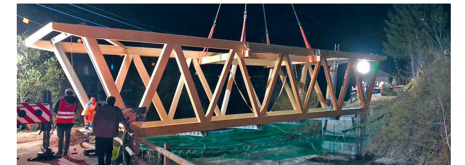
Das vormontierte Fachwerk wird mit einem Pneukran in die Widerlager gehoben.
