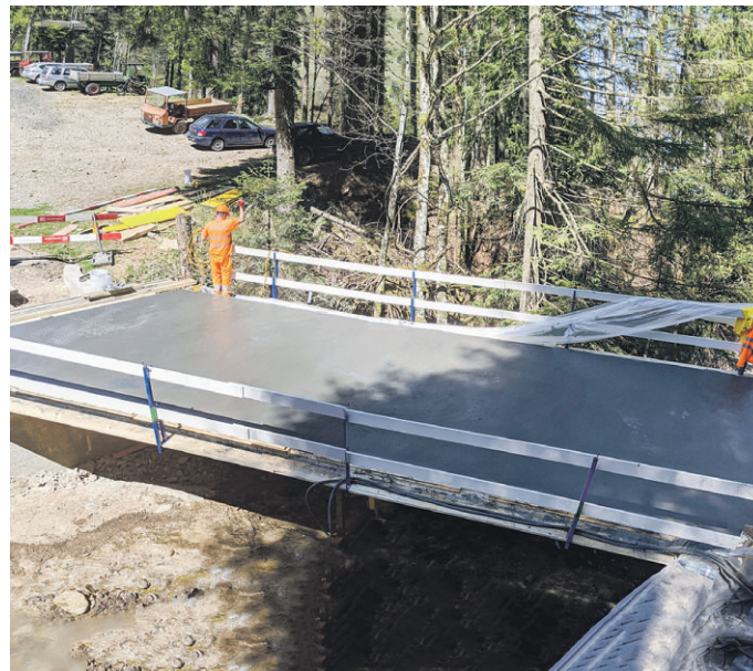
Die UHFB-Fahrbahn ist auch ein Witterungsschutz für die Holzträger.
