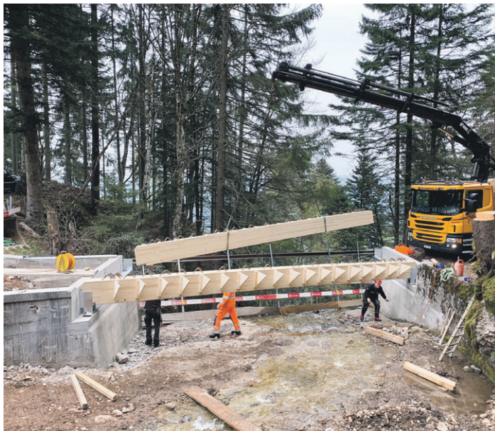
Die Brettschichtholz-Träger werden versetzt.
