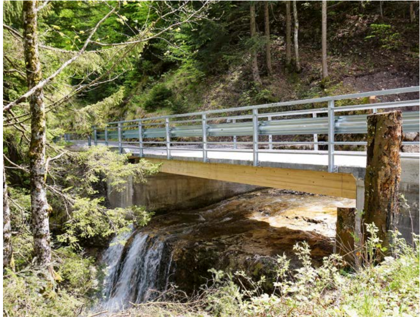
Die Fruttlibrücke in Arth ist die schweizweit erste Holz-UHFB-Verbundbrücke, die für 40-Tonnen-Lasten ausgelegt ist. Sie spielt eine wichtige Rolle im regionalen Holz- und Gütertransport.
