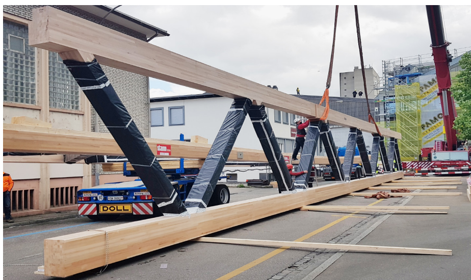
Die drei 36 Meter langen und 4.50 Meter hohen Fachwerkträger wurden liegend auf zwei Tiefladern von Lungern OW nach Basel gefahren.
