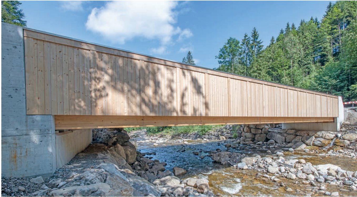
Gut 24 Meter weit spannt sich seit letztem Sommer die neue Stillaubbrücke über die Grosse Entlen. Das Bauwerk ist auf eine Nutzungsdauer von 80 Jahren angelegt.
