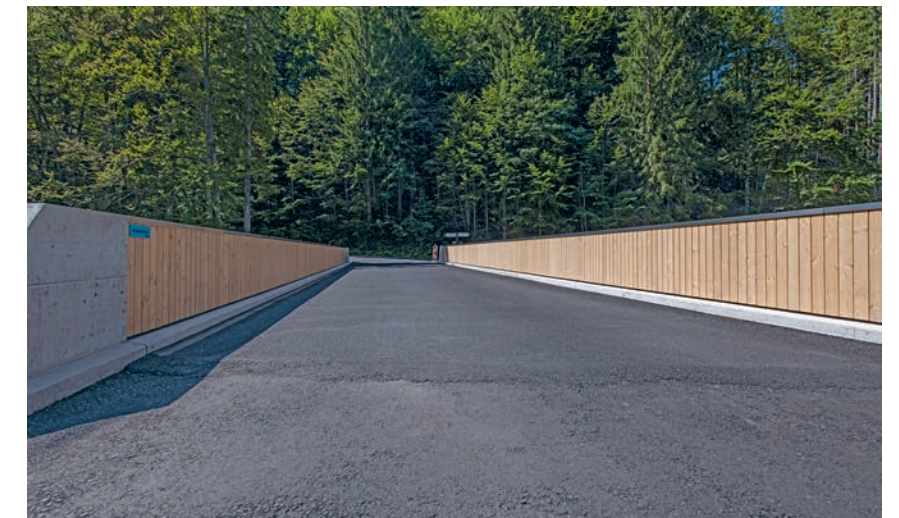
Das Holz-Beton-Verbundbauwerk misst 6,30 Meter in der Breite und 1,12 Meter in der Höhe.
