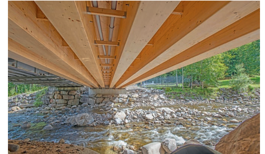
Sechs Holzbalken tragen den Schwerlastverkehr von bis zu 40 Tonnen. Links neben der neuen Holzkonstruktion ist noch die alte Notbrücke aus Stahl von 1996 zu erkennen.
