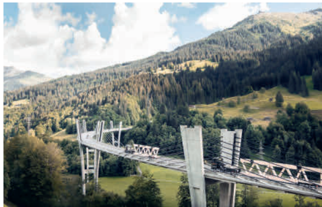
▲ Fachwerktransport. Foto: Künzli Holz AG
