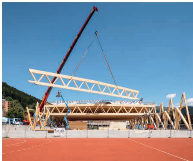
▲ Fachwerkmontage. Foto: Künzli Holz AG
