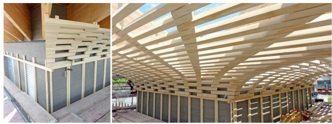
Die massgenaue Vorfertigung der Auskleidungselemente für die BSH-Tragstruktur erwies sich vom Anfang (links) bis zum Ende der Montage (rechts) als die richtige Massnahme.
