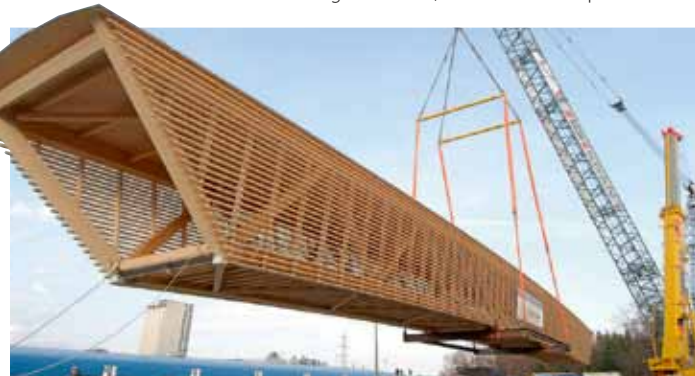
Diese Fußgängerbrücke mit GSA-System wurde im April montiert – die Spannweite beträgt 59 m
