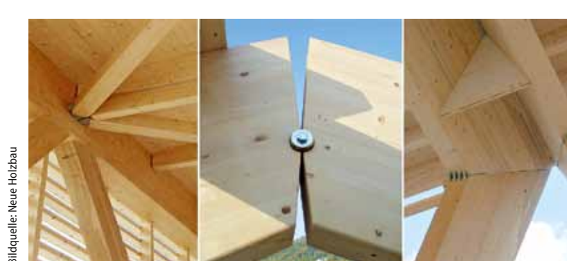
Filigrane Verbindungen erlaubt die GSA-Technologie: Wenn es der Architekt wünscht, verschwinden die Stahlteile (fast) vollständig
