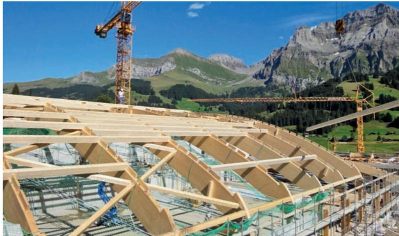
In zwei Binderfeldern wurden Windverbände (oben) angelegt. Das Sekundärtragwerk besteht aus Sparrenpfetten (siehe Luftbild). Ungeachtet des beachtlichen Bauvolumens ist die lokale Einbindung der Freizeit- und Sportarena in den zentrumsnahen Bereich Adelbodens (unten) gelungen.
