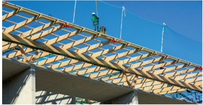
Die Arbeiter montieren Buchen-BSH als Primärtragwerk von Pultdächern
