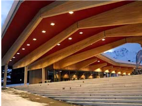
Abb. 1 - Das im vergangenen Sommer fertiggestellte Gebäude der Skischule in Arosa mit Trägern aus Eschen- und Fichtenholz. Foto: Lukas Denzler
