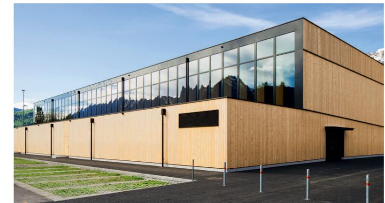
Das grosse Volumen des Hallenbaus weist eine Staffelung in der Höhe auf, sodass ein grosser Flächenanteil der nach Nordost orientierten Längsfassade über dem Geräteraum verglast werden konnte.
