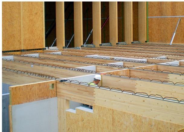
Bei der Ausführung der HBV-Zwischendecke (rechts, oben) im zweigeschossigen Garderobengebäude gelangten, um den höher belasteten Bereichen Rechnung zu tragen, Unterzüge aus kombiniertem Brettschichtholz (Esche/Fichte) zum Einsatz (rechts, unten).
