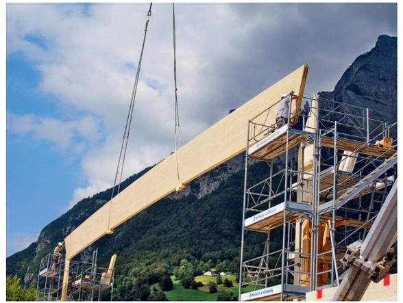
Die brettschichtverleimten Primärträger für die Rahmenkonstruktion weisen einen selten anzutreffenden Schlankheitsgrad auf.
