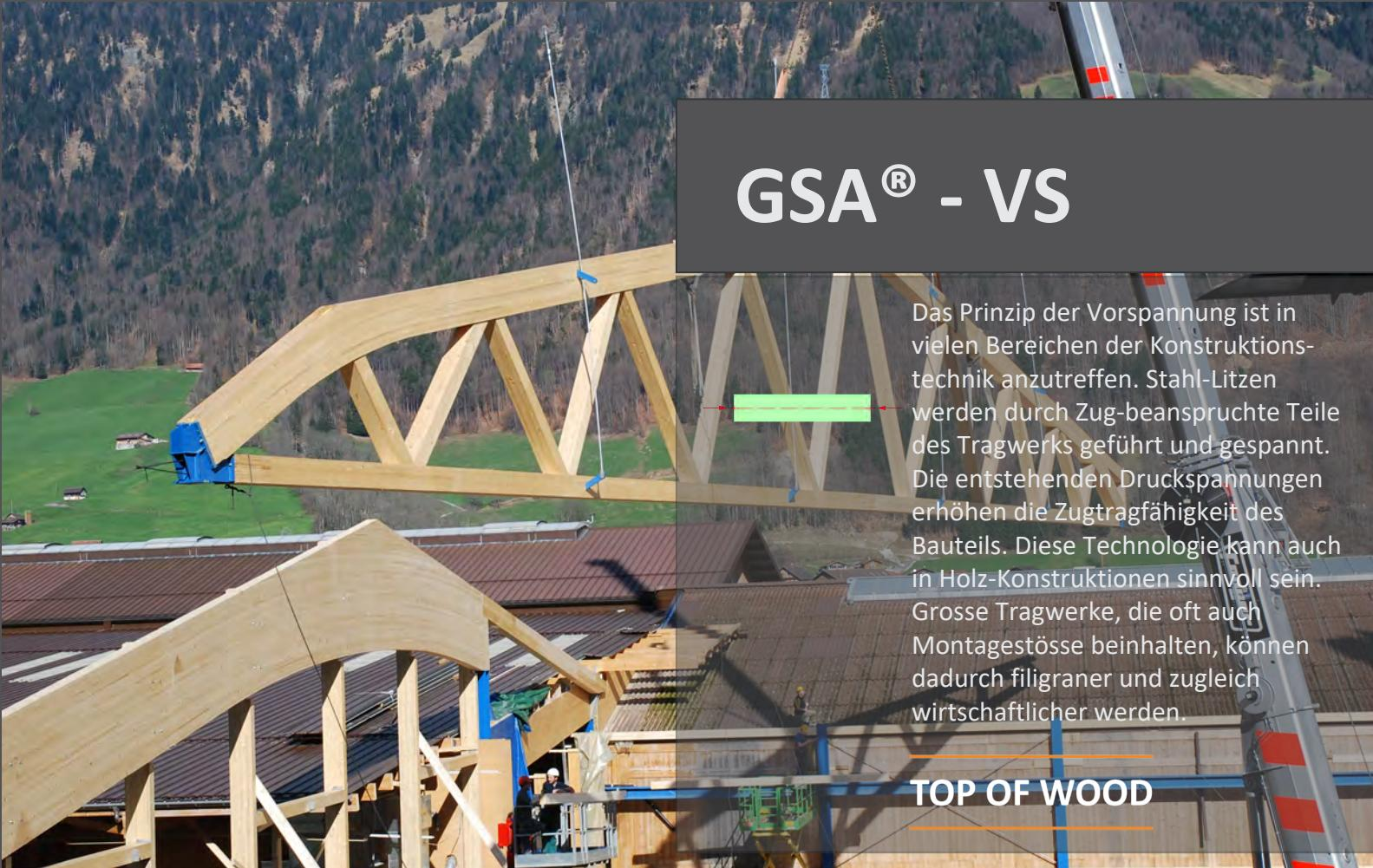
Das Prinzip der Vorspannung ist in vielen Bereichen der Konstruktions-technik anzutreffen. Stahl-Litzen werden durch Zug-beanspruchte Teile des Tragwerks geführt und gespannt. Die entstehenden Druckspannungen erhöhen die Zugtragfähigkeit des Bauteils. Diese Technologie kann auch in Holz-Konstruktionen sinnvoll sein. Große Tragwerke, die oft auch Montagestösse beinhalten, können dadurch filigraner und zugleich wirtschaftlicher werden.
