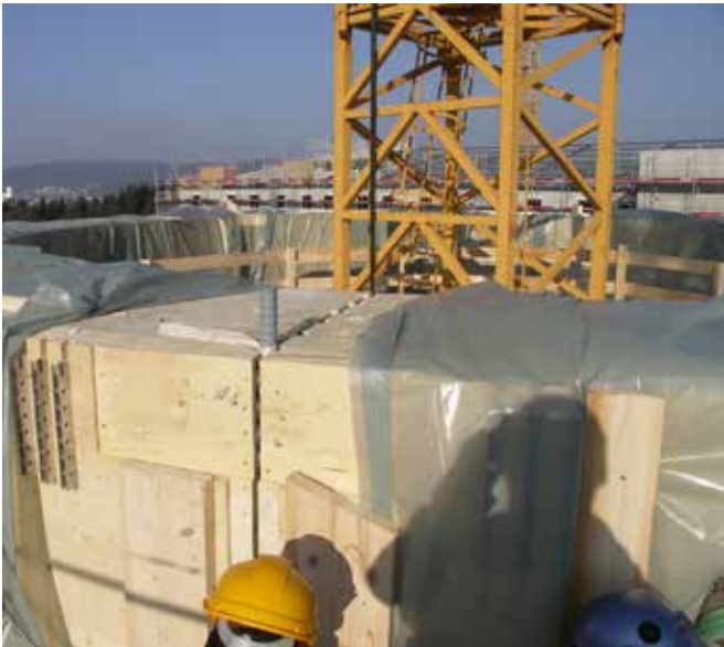
Bild 4a: Baustellenstoß Firstring
