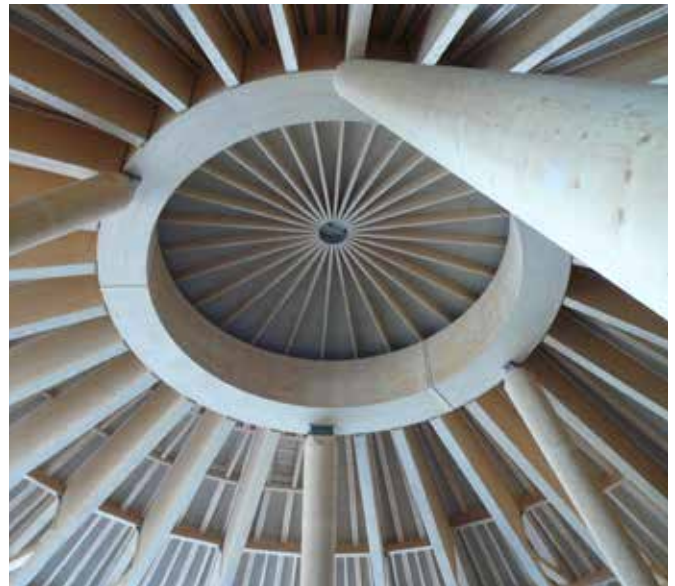
Bild 4b: Unteransicht Firstring
