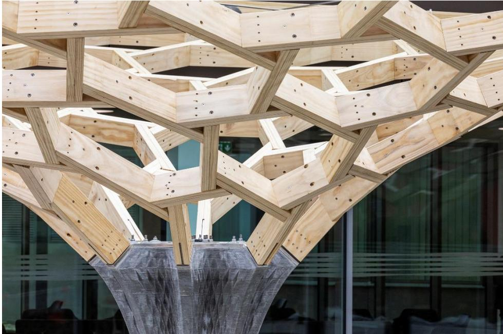
3. Fließender Übergang trotz unterschiedlicher Materialien: Durch die aussergewöhnliche Formgebung der Betonstütze wächst die «Krone» quasi aus dem «Stamm» heraus. © Basler & Hofmann AG / Stefan Kubli
