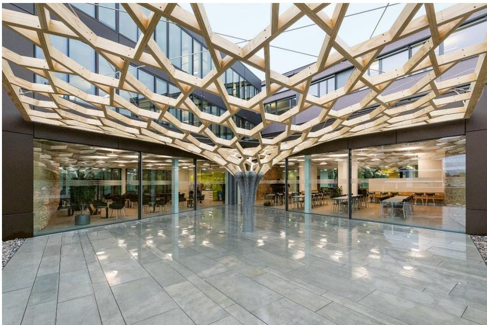
2. Das Holzdach des Future Tree besteht aus reziproken Knoten. Im parametrischen Modell konnten unter anderem die Maschenweite und die Wölbung angepasst werden. © Basler & Hofmann AG / Stefan Kubli
