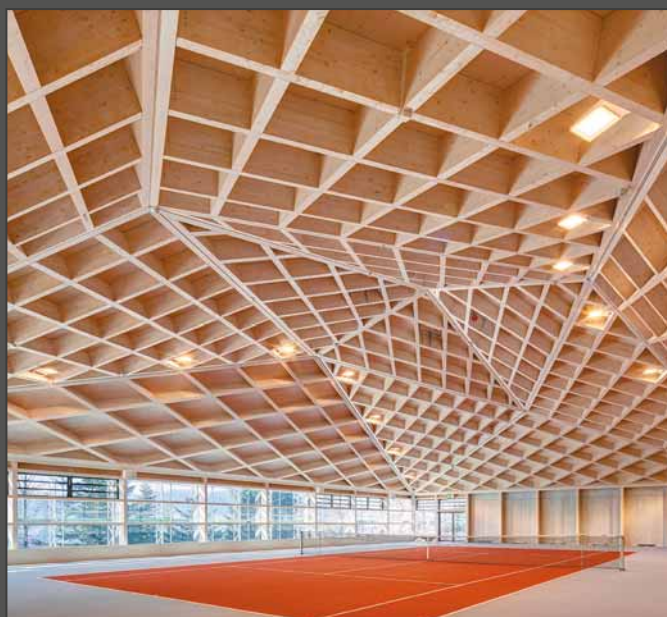
Neubau Tennishallen, Bürgenstock Hotels & Resort, Obbürgen 7)
