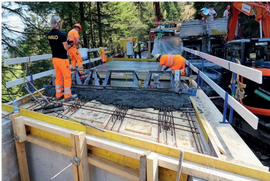
6 Ausführung der UHFB-Arbeiten am Überbau © Ingenieurbüro Edgar Kälin AG
