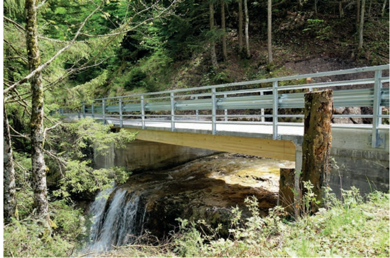
1 Neues Brückenbauwerk nach Fertigstellung © Ingenieurbüro Edgar Kälin AG
