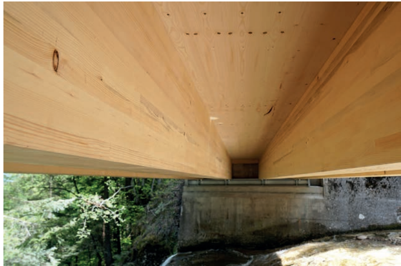
3 Erscheinungsbild der Unterseite aus Holz © Ingenieurbüro Edgar Kälin AG
