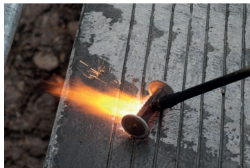
7 Abflämmen der aufstehenden Stahlfasern © Ingenieurbüro Edgar Kälin AG
