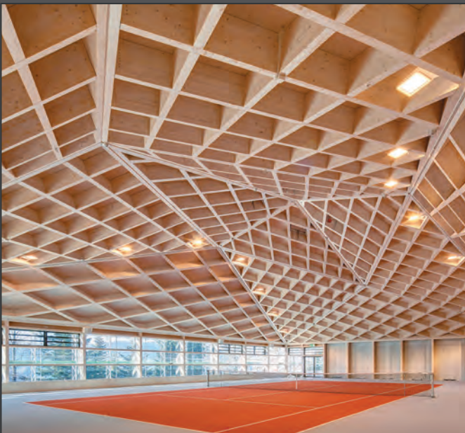
Neubau Tennishallen, Bürgenstock Hotels & Resort, Obbürgen 7)
