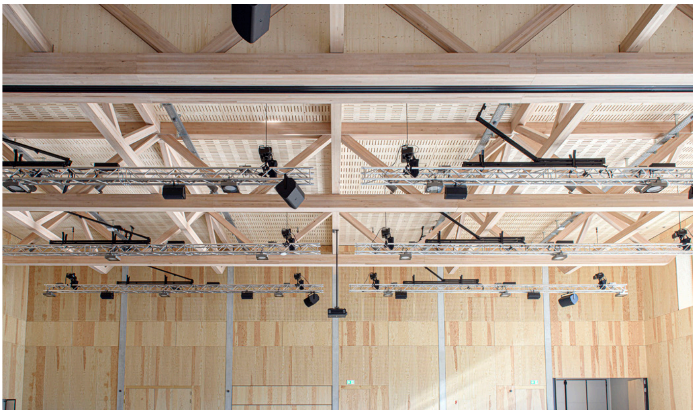
Das Tragwerk und die Verbindungsmittel stellte das Ingenieurholzbauunternehmen neue Holzbau her. Die Tragwerksplanung führte Pirmin Jung Schweiz durch
