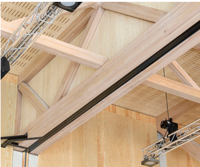
An dem doppelten akustisch abgekoppelten Fachwerk ist die mobile Trennwand aufgehängt
