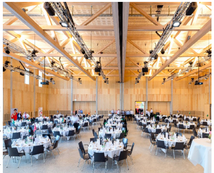
Rund 1000 Personen passen in die flexibel nutzbare Eventhalle. Auf Initiative des Holzbauers wurde das Tragwerk in Buchenstabschichtholz ausgeführt
