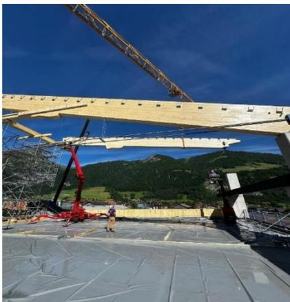
Abbildung 2 Aufrichten der Satteldachbinder
